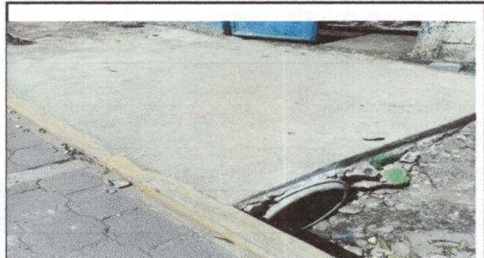
Foto 4: Sustrucción de tubería pvc por tubería de concreto línea principal de aguas pluviales
