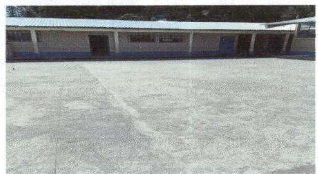
Foto 2: Reparación de piso de cemento líquido
