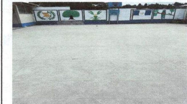
Foto 1: Sustrucción de piso de tierra por torta de concreto
