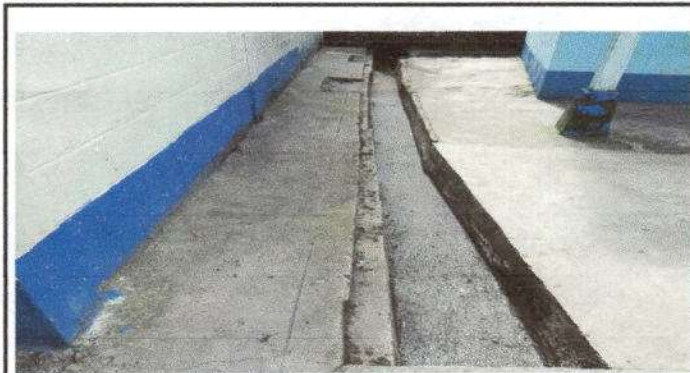
Foto 3: Reparación de banqueta de concreto
