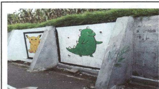
Foto 5: Reparación de muro perimetral
