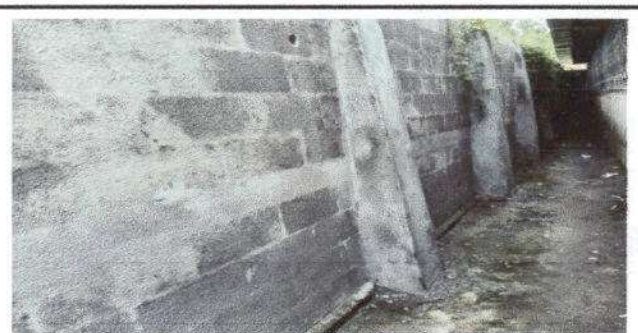
Foto 6: Reparación de block del muro perimetral
